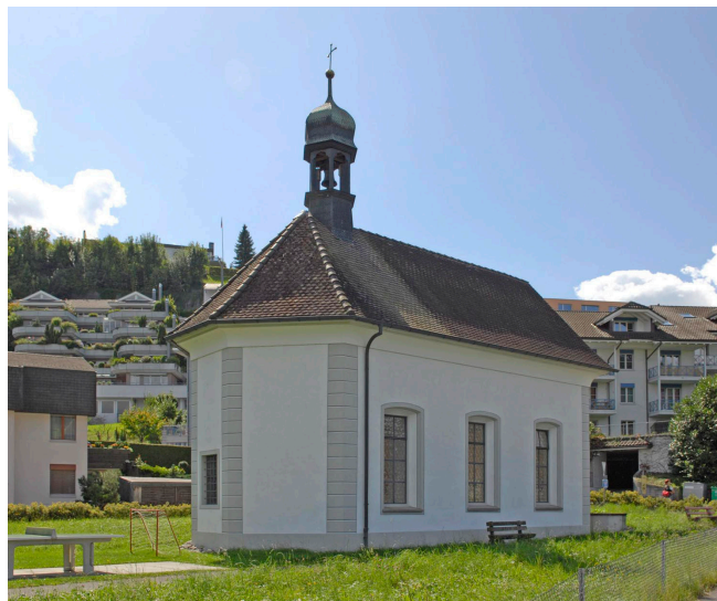
Bild oben: Ansicht von Nordwesten Bild unten: Ansicht von Nordosten
