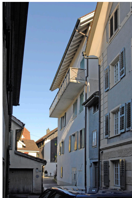
Bild oben: Ansicht von Nordosten
