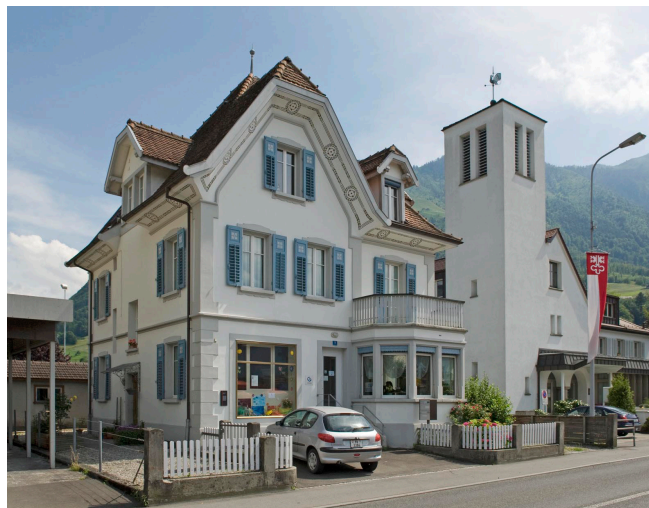
Bild oben: Ansicht von Westen Bild unten: Ansicht von Norden
