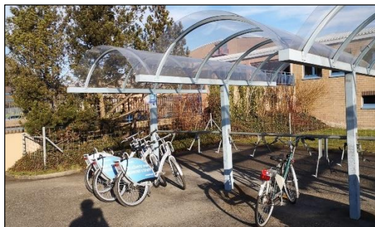
Abb. 28, 29 Veloabstellanlage mit schlechtem Halterungssystem (Eichli)
